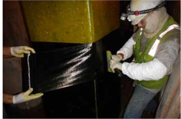
*Syntho-Glass® XT fue diseñado para proporcionar resistencia estructural y sellado de fugas para evitar cierres inesperados en refinerías.*
