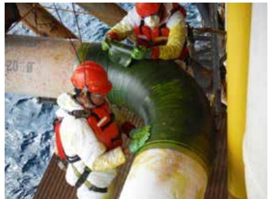
*Los técnicos aplican Thermo-Wrap™CF, un compuesto de fibra de carbono de alta resistencia personalizado, en un codo de 20" de diámetro exterior de una plataforma petrolera mar adentro ubicada en Brasil.*
